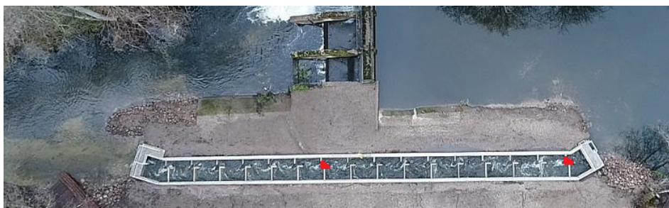
Fot. 4. Przepławka przy jazie Sówka z zaznaczonymi miejscami instalacji anten RFID (Fot. Marcin Budniak, TPRIIG)
